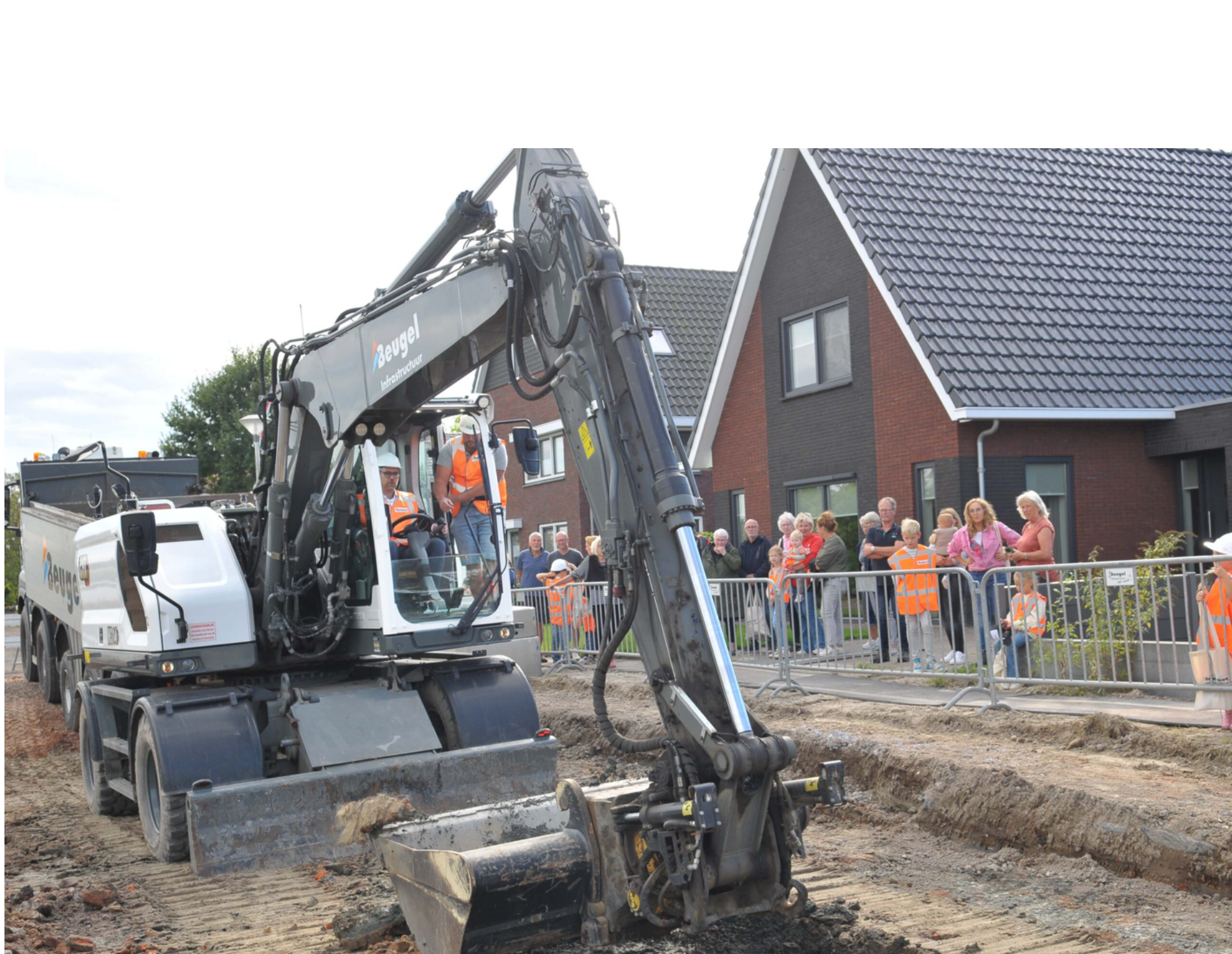
Stefan van Keijzerswaard in opperste concentratie op de mobiele kraan om een start met de aanleg van de riolering te maken.
